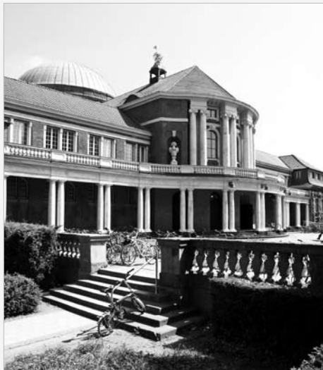
Hauptgebäude Edmund-Siemers- Allee 1
